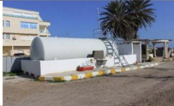
Parc du matériel, aire de stationnement, zone de stockage déchets dangereux, etc...
